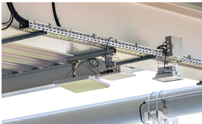
Point d'accès extérieur LANCOM OX-6400 avec antenne sectorielle AirLancer ON-Q30 : placée en hauteur sur le toit du stade, cette combinaison assure une couverture Wi-Fi étendue et performante dans les tribunes du stade Heinz-Steyern.
